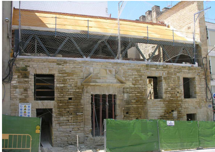
Fig 7. Muro de fachada en el proceso de restauración y restitución de piezas. 2011. ARQVIPO.
