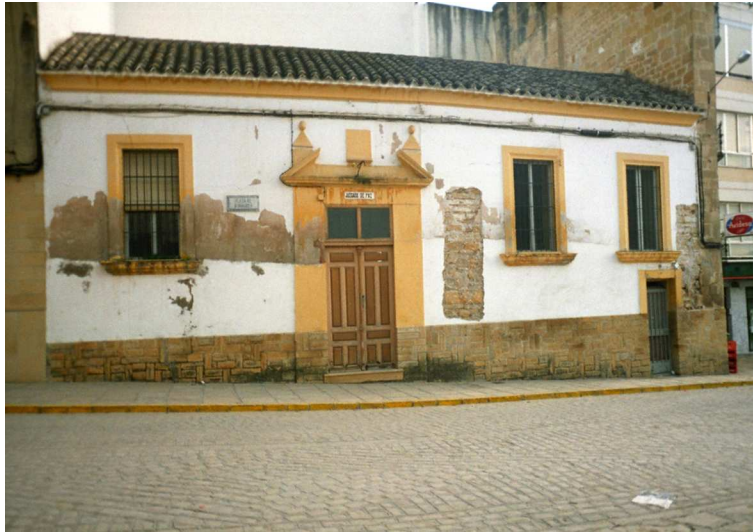
Fig 1. Edificio antes de ser intervenido. 2001. Fototeca ARQVIPO.
