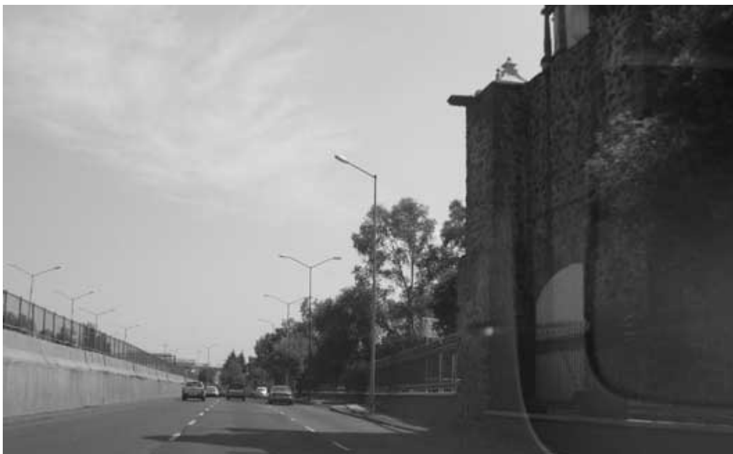
Fig. 5: Fotografía tomada sobre el Periférico norte al pasar por el ala oeste del ex templo. Nótese como una de sus puertas, en color blanco, se encuentra tapiada. La construcción es de cal y canto y destaca entre todas las construcciones a lado de las cuales pasa la autovía. Tomada en junio del 2009.
