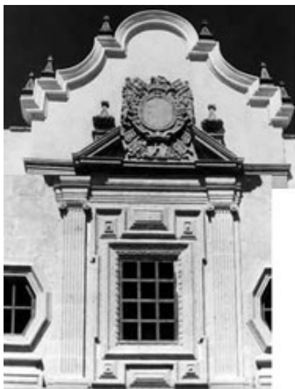
Fig. 33: Detalle de los tres cuerpos de la fachada.
