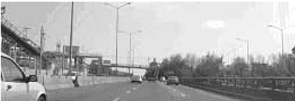
Fig. 4: Fotografía tomada sobre el Periférico norte, antes de pasar al ex templo ubicado del lado derecho donde se asoma una de sus cúpulas que es de color rojo. Tomada en junio del 2009.
