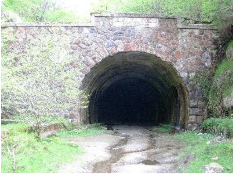
Túnel de La Engaña (Línea Santander-Mediterráneo) Fotografía Belkis Rojas y Jorge Magaña
