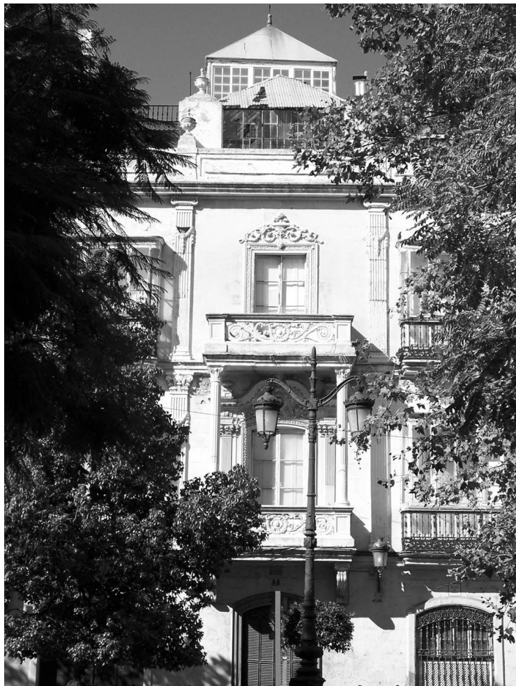
Figura 8. C/. Plaza de Mina nº 11.
