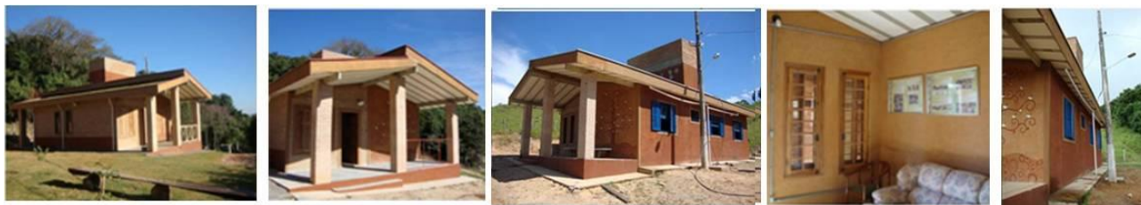
Figura 9: Imagens da Casa de apoio, após a sua conclusão. Fonte: GEAHAS, 2010.
