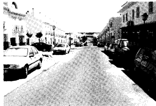
Figura 13 Calzada y acerado en el PP-1.
