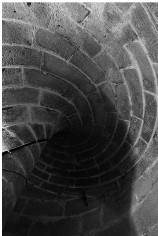
Figura 8 Escalera de caracol en vía de San Gil en la iglesia de San Juan de los Caballeros en Jerez de la Frontera (Cádiz)
