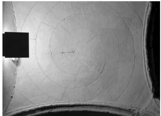
Figura 6 Bóveda baída helicoidal en el vestíbulo de acceso a la escalera de las Salas Altas de la iglesia Mayor de Medina Sidonia (Cádiz)
