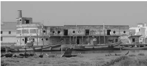
Figura 1 Estado actual de la antigua Lonja. Fachada al río Barbate. Julio de 2004
