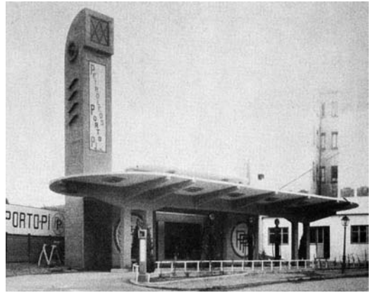
Figura 3 Estación de Porto-Pí
