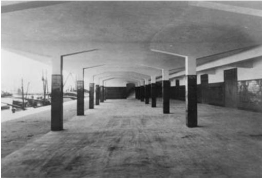
Figura 7 Estado de la Lonja hacia 1944. Fuente: Programa de Intervención en el Patrimonio Público de Interés Arquitectónico. Junta de Andalucía
