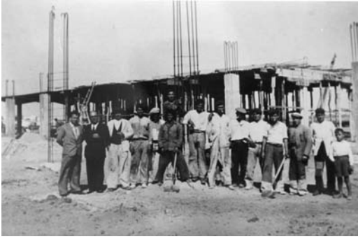
Figura 2 Casto Fernández Shaw en la obra de la lonja de Barbate. Hacia 1941
