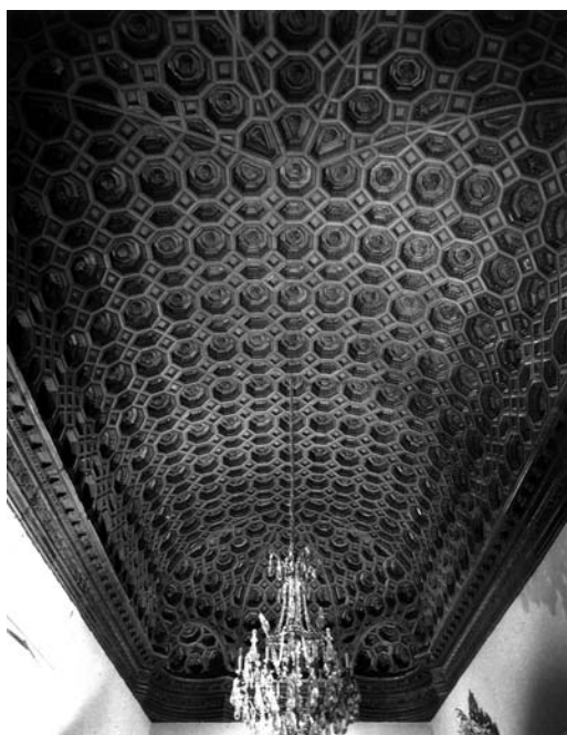
Figura 7 Armadura de la Sala de Fumar
