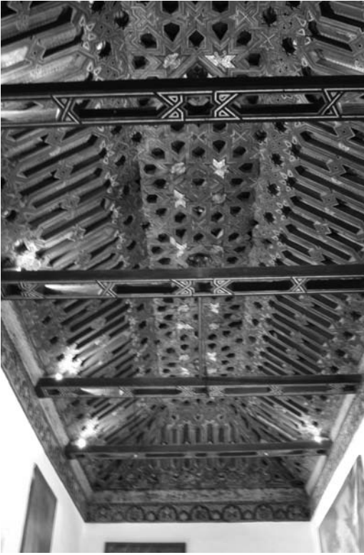
Figura 2 Armadura que cubre el Vestíbulo de acceso al Palacio Alto
