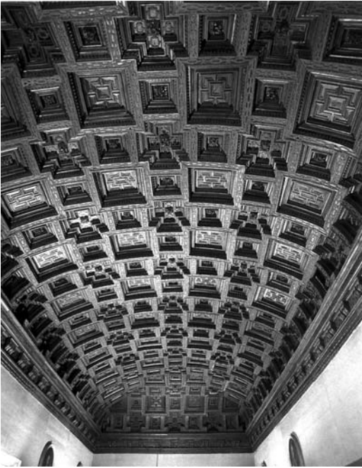
Figura 8 Armadura de la Sala de Billar
