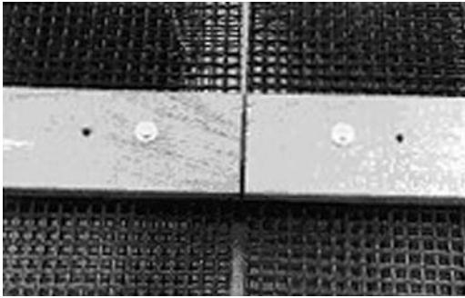
Figura 15. Pabellón de Checoslovaquia Expo '92. Tablas de madera de iroko y fijaciones de acero inoxidable. Fuente: E. Morales. AITIM 220
