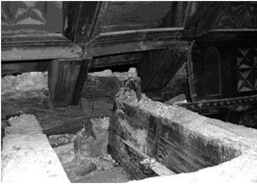
Figura 10 Clavija de refuerzo en un ejemplo de carpintería de armar española (Candelas Gutiérrez 2001)
