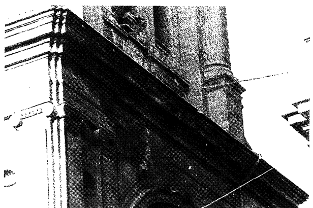
f) Picados y alveolizaciones en la torre.
