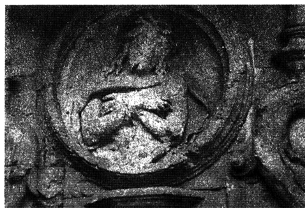
f) Disyunciones y arenizaciones en las figuras.
