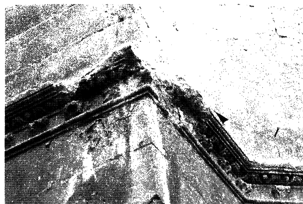
e) Fragmentaciones en molduras y separación de películas.
