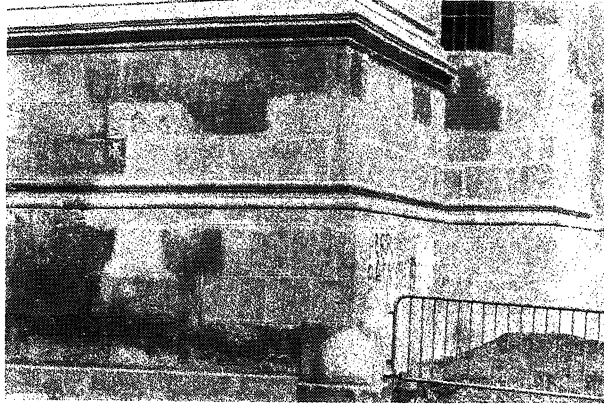
a) Sustituciones en sillares.
