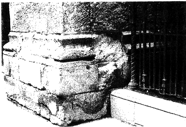
c) Arenizaciones por humedad ascendente. c) Grain disgregations due to rising damp.
