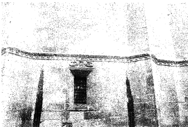
a) Pátina. Efecto de una antigua protección.
