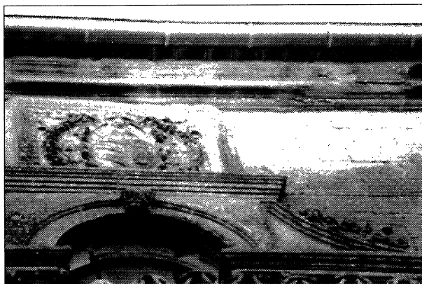
e) Arenizaciones y disyunciones de placas.
