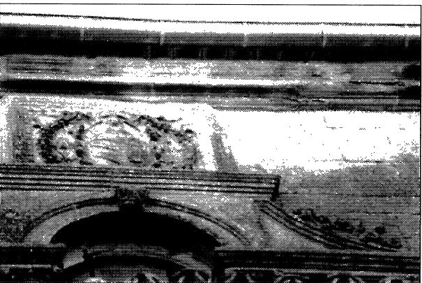
e) Arenizaciones y disyunciones de placas.
