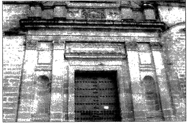
b) Pátina en diversos litotipos. Fractura.
