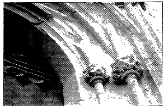
d) Fracturaciones y fragmentaciones.
