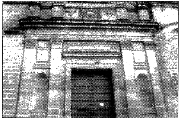
b) Pátina en diversos litotipos. Fractura.
