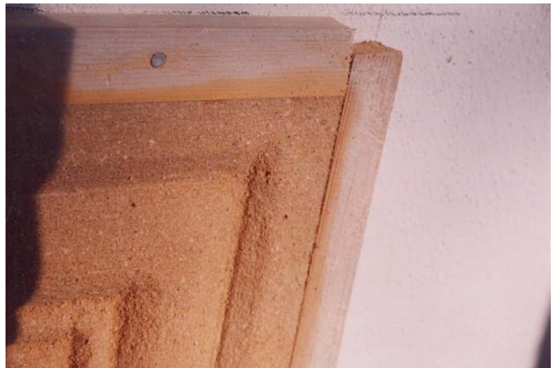
Figura 18. Reglas auxiliares, para sobre ellas desplazar la terraja.
