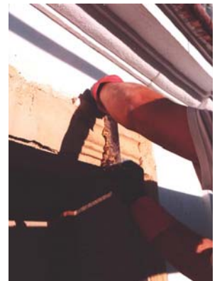
Figura 19. El operario traslada la terraja guiada por una regla arrollando el mortero de cal que previamente se ha colocado en el lugar que debe de ir la moldura.
