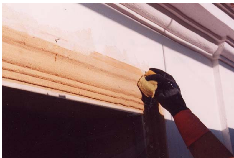
Figura 21. Esponjado con una esponja húmeda, cuando se va secando el mortero, eliminando los granos del árido que aflora a la superficie y quitando irregularidades.
