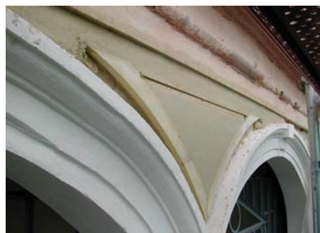
Figura 23. Reglas curvas de madera empleadas para la elaboración de las molduras de los triángulos curvos centrados en las enjutas de los arcos.
