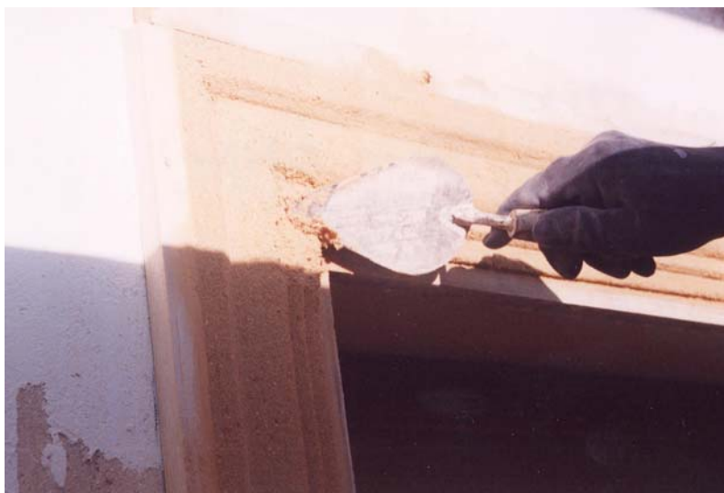
Figura 20. Repaso del terrajado con el palustrillo o paletín en estado plástico, perfilando los bordes de la geometría de la moldura.
