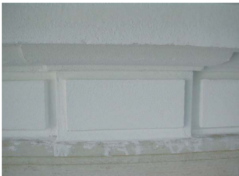
Figura 27. Capa de mortero de estuco blanco sobre los morteros de cal de los terrajados de la molduración del entablamento con decoración geométrica, alternando rectángulos y cuadrados.
