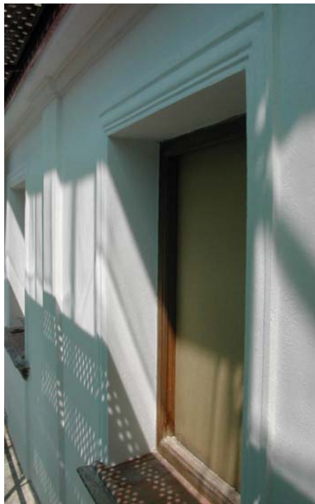
Figura 26. Capa de mortero de estuco blanco sobre los morteros de cal de revestimiento, los terrajados de las ventanas y las cornisas en la fachada manierista.
