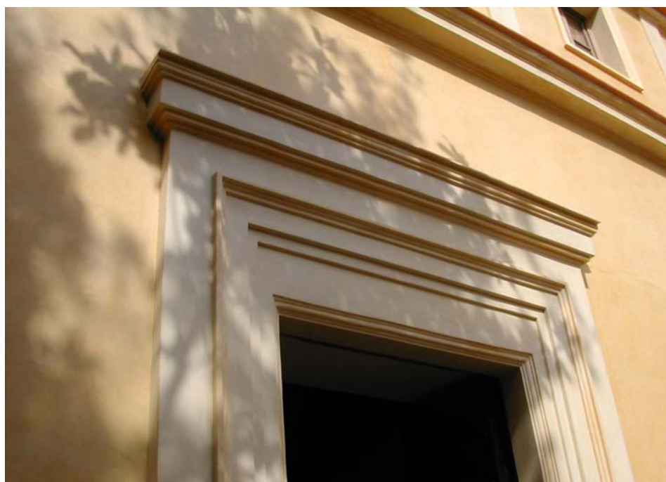
Figura 29. Detalle de la parte superior de la portada terrajada y estucada de la fachada norte.
