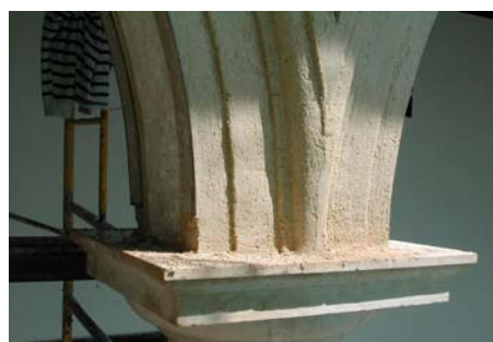
Figura 24. Revestimiento con mortero de cal y terrajado en el arranque de la molduración de las roscas de los arcos.
