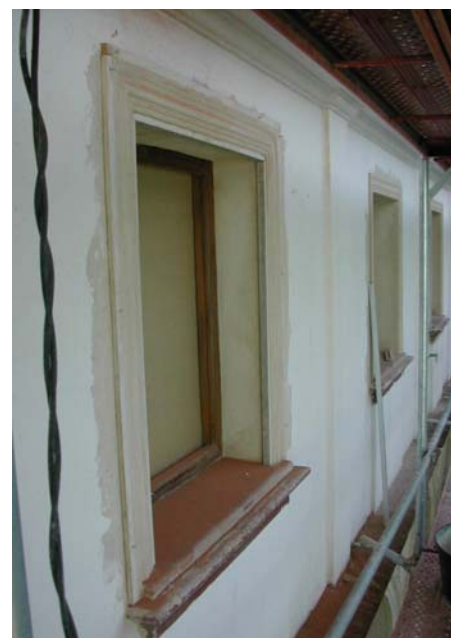
Figura 25. Enmarcados de las ventanas hechos con terrajas.
