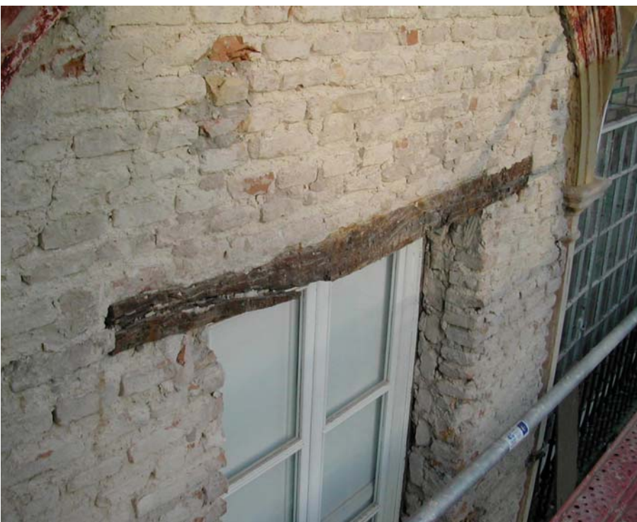
Figura 10. Vista parcial de una zona de muro picado.
