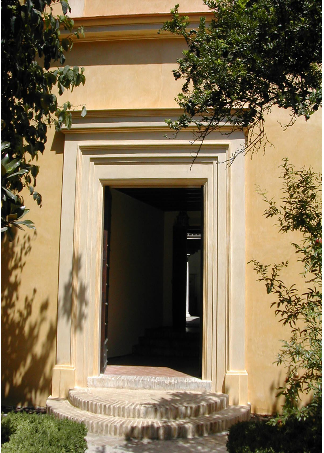
Figura 30. Portada terrajada y estucada de la fachada norte.
