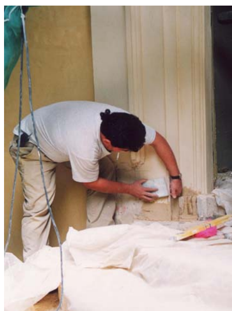
Figura 21. Esponjado con una esponja húmeda, cuando se va secando el mortero, eliminando los granos del árido que aflora a la superficie y quitando irregularidades.
