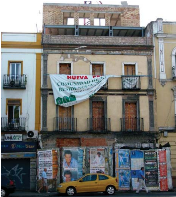
Remonte en María Auxiliadora 10. Edificio original de Anibal González.
