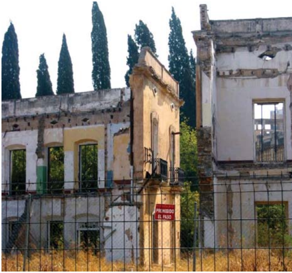
Pabellón de Gobierno de la Pirotecnia.
