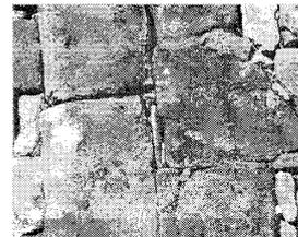
Huellas en la piedra: desgaste de pisadas; pavimento modificado para la entrada; colocación de sumidero; marca del antiguo límite de la granja
