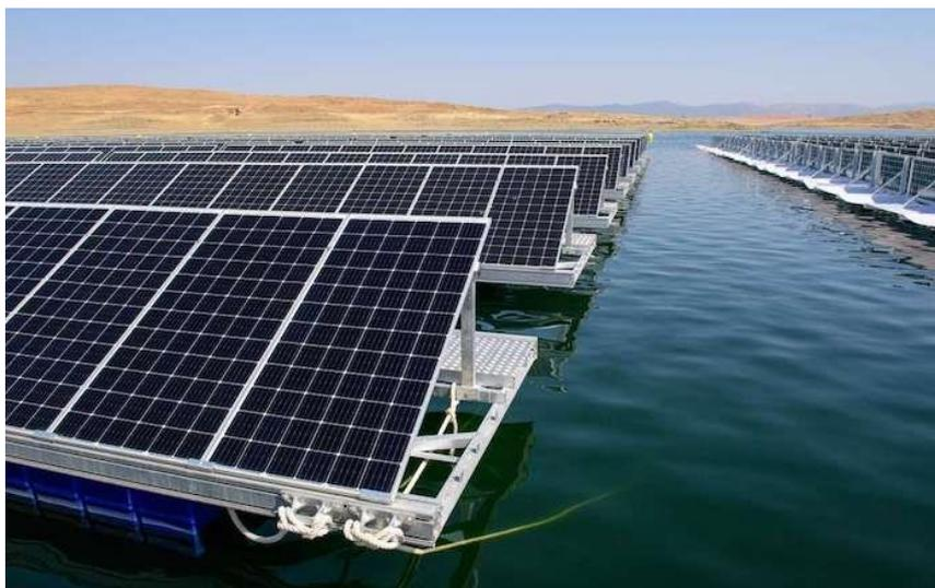
Figura 12: Sistema con estructura flotante (24)
