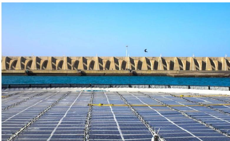
Figura 7: prototipo de FPV marina en la Palma (14)
