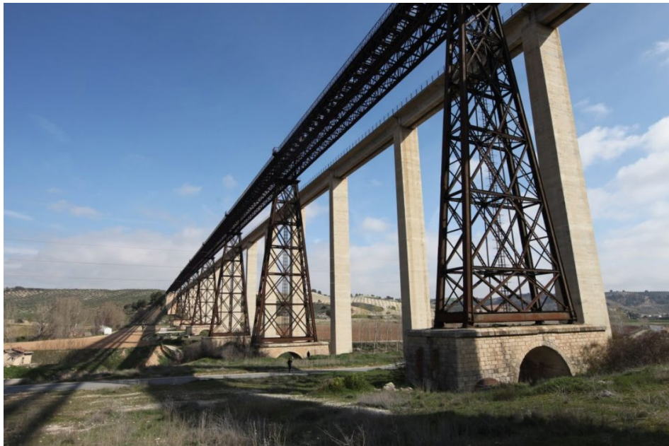
Figura 1-2. Puente del Hacho perteneciente a la línea Linares-Almería [4].
