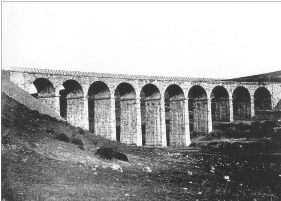
Figura 1-1. Viaducto de Celada recién construido, año 1856 [2].
