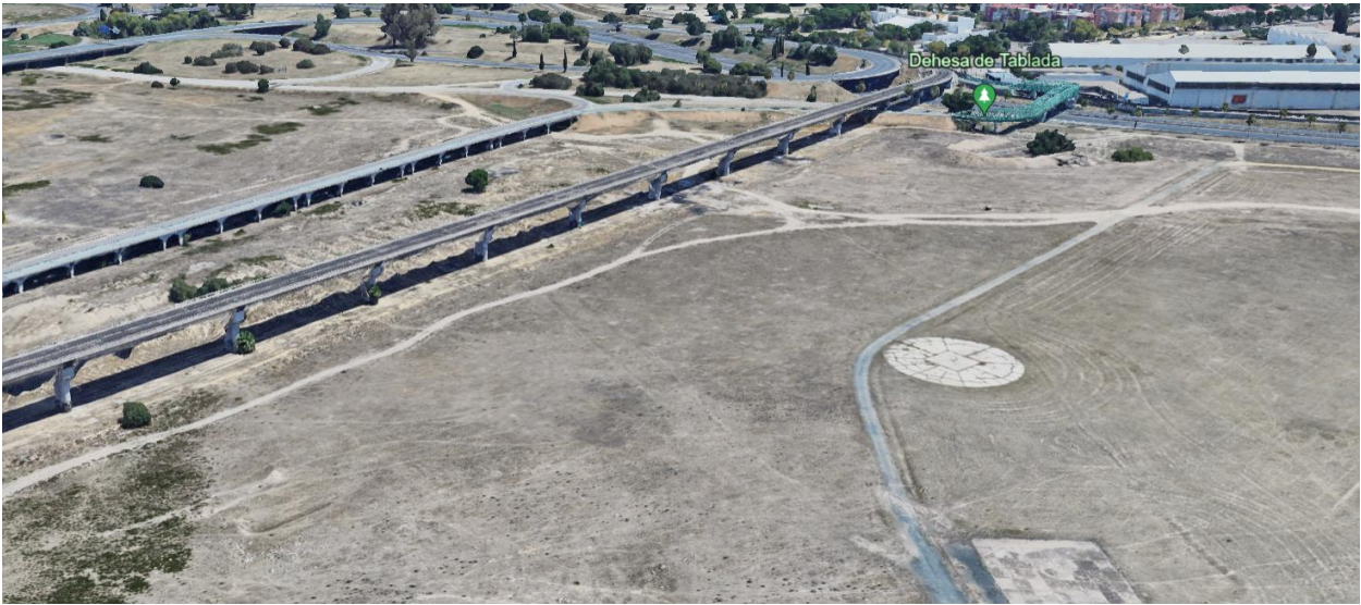
Figura 4.4.b Vista aérea de la estructura (2).
