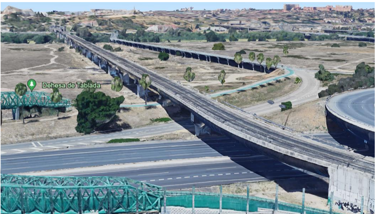
Figura 4.5 Vista trasera de la estructura.
