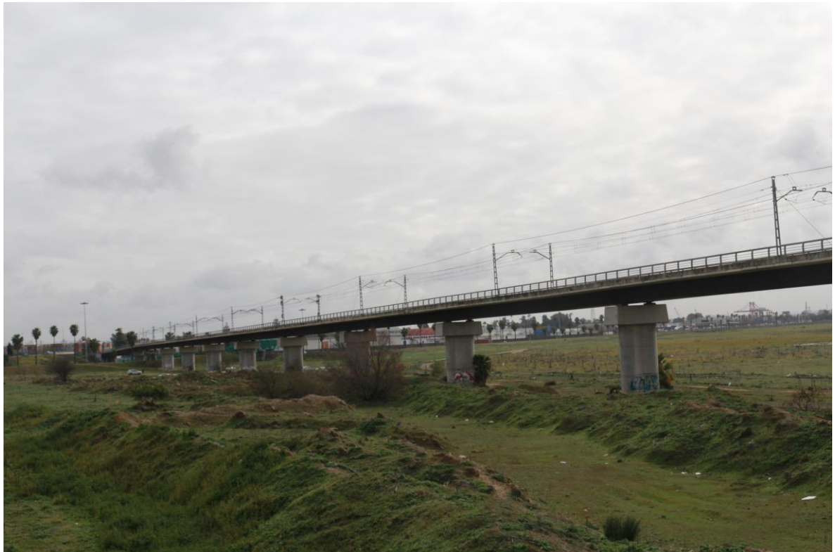
Figura 4.7 Vista longitudinal de la estructura.
