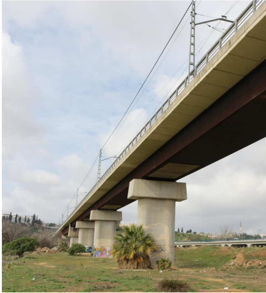
Figura 4.6 Vista contrapicada de la estructura.
