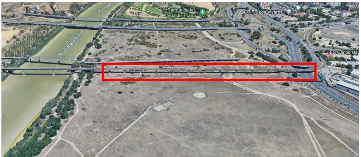
Figura 4.4.a Vista aérea de la estructura (1).
