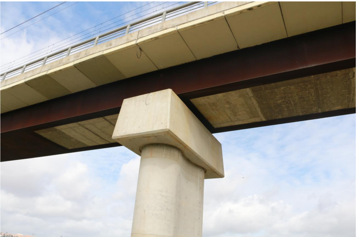
Figura 4.9 Vista contrapicada de uno de los apoyos de la estructura.
