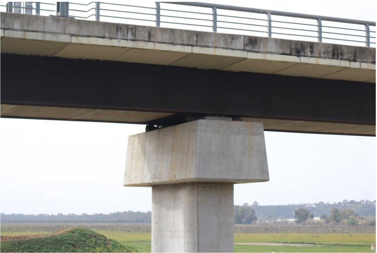
Figura 4.8 Vista próxima a un apoyo de la estructura.
