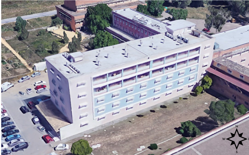
Figura 27. Edificio con referencia cardinal
