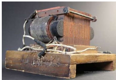
FIGURA 1.1. PRIMER TRANSFORMADOR DE POTENCIA COMERCIAL DESARROLLADO POR G. WESTINGHOUSE (1886).
