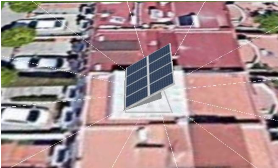
Figura 5-6. Vista lateral de la estructura soporte de los paneles.
