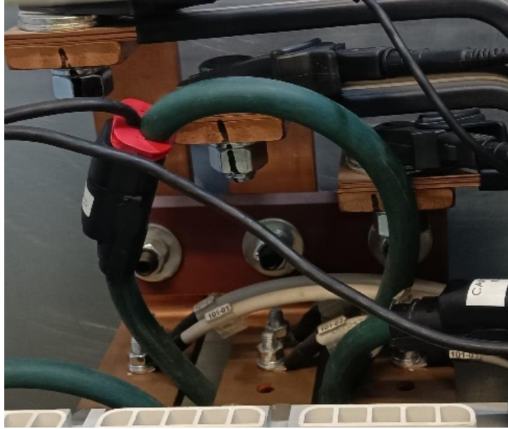
Figura 71- Imagen 1 de la colocación de los toroidales en las pletinas
