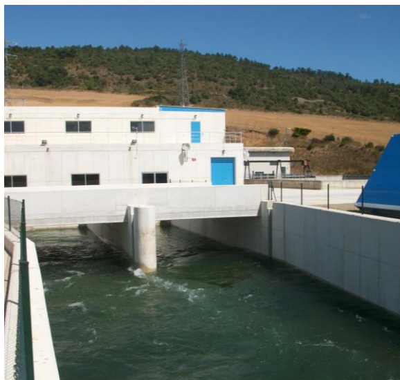
Ilustración 18. Canal de desagüe de la CH Toma del Canal. Fuente: (CANASA, 2024)
