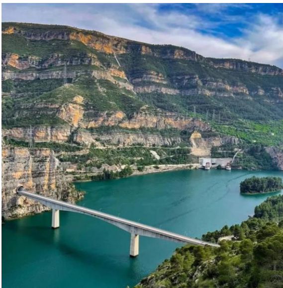
Ilustración 22. Embalse de Cortes-La Muela, depósito inferior de la CH de bombeo La Muela II. Fuente: (Eva, 2024)
