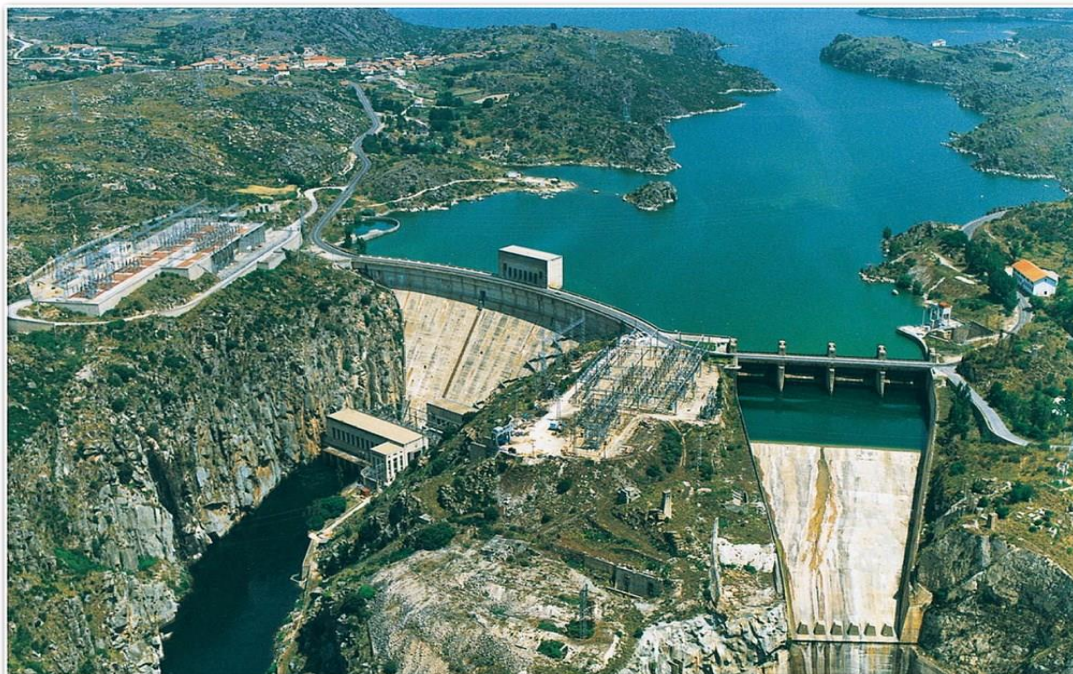
Ilustración 38. Presa de Ricobayo, primera gran central hidroeléctrica, año 1935
