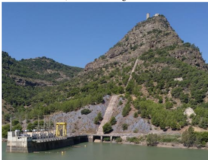
Ilustración 13. CH Tajo de la Encantada.
