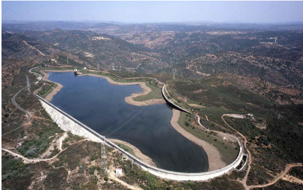
Ilustración 33. Depósito superior de la Central Hidroeléctrica de bombeo, Guillena.
