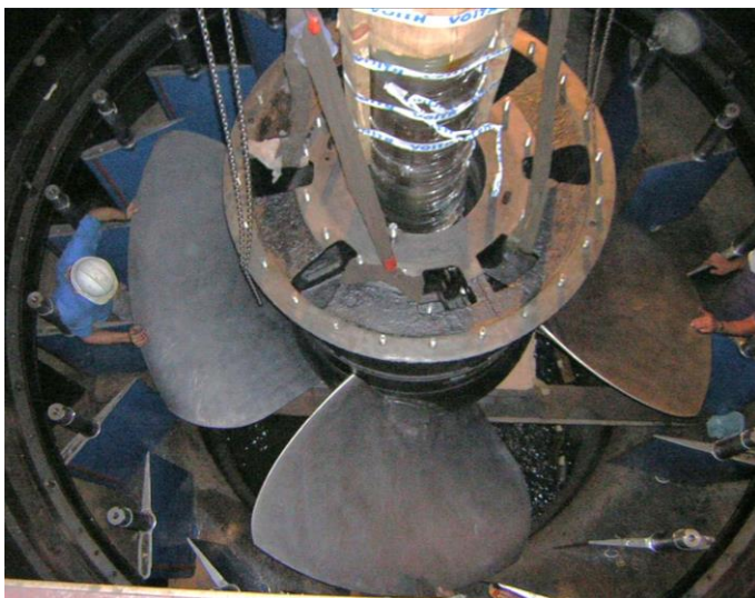
Ilustración 27. Colocación del rodete de la CH de Alcalá del Río. Fuente: Ramón Abella.
