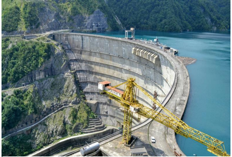
Ilustración 10. Presa de la CH de Inguri (1300 MW), Georgia.
