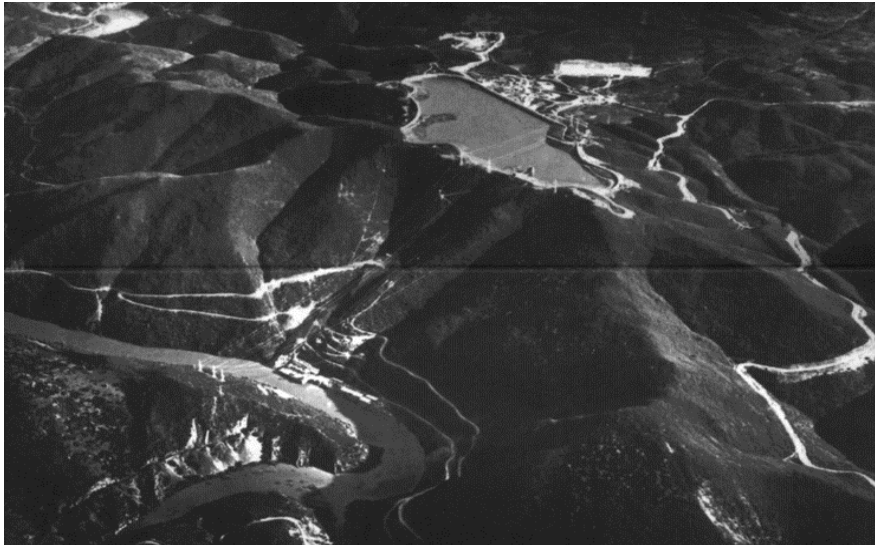
Ilustración 35. Imagen aérea del deposito superior y de la CH de Guillena sobre el río Rivera de Huelva. Fuente: Ramón Abella.
