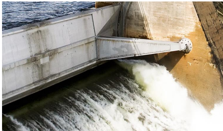
Ilustración 20. Ejemplo compuerta radial permitiendo la salida parcial del agua embalsada.
