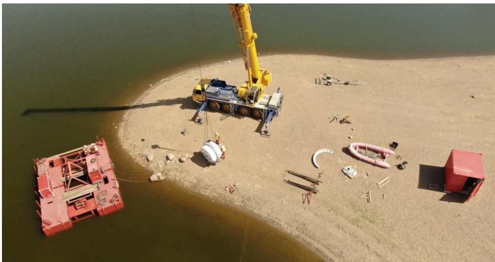
Ilustración 36. Preparación para la colocación de la nueva válvula. Imagen aérea del tapón en grúa. Fuente: (Endesa proyectos de renovables, 2024)
