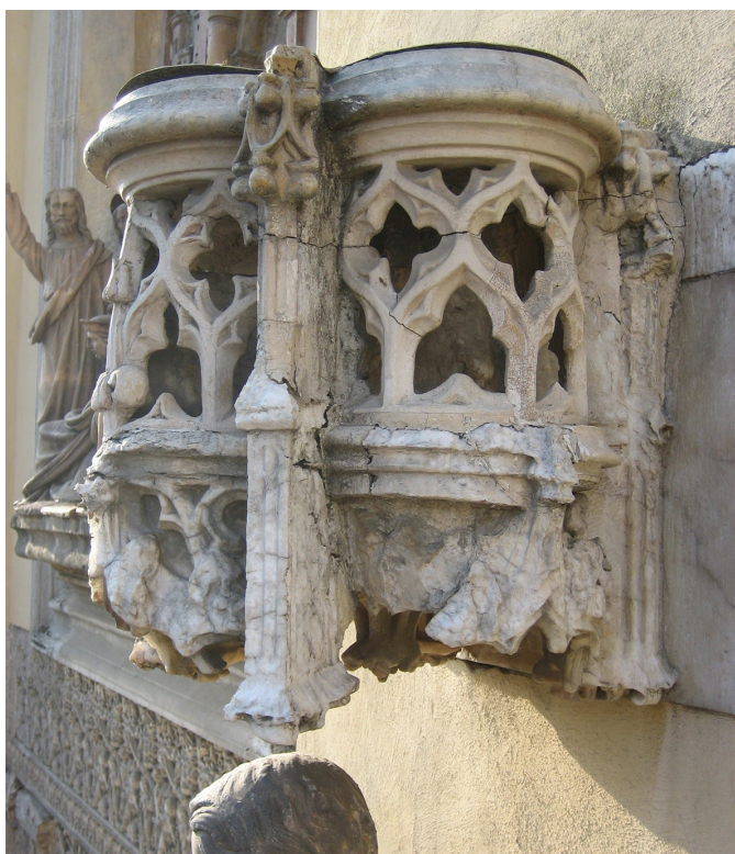
Fig. 4 Puerta del Perdón. Estado previo al mantenimiento 2006
