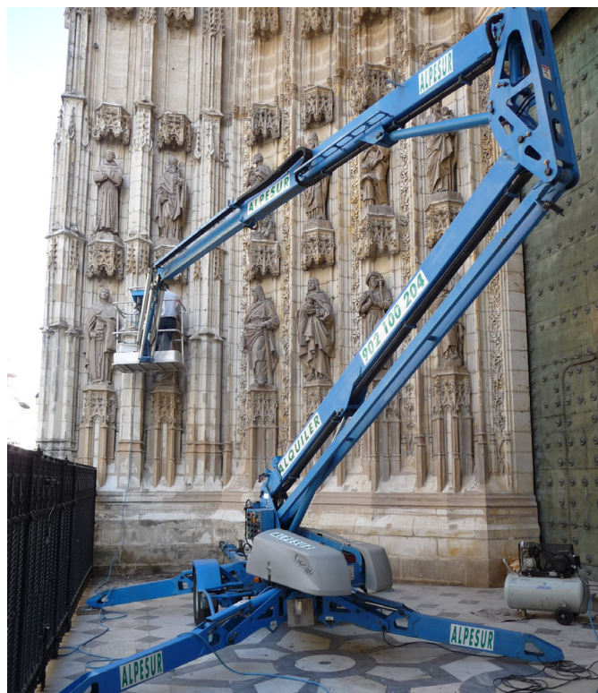
Fig. 5 Portada la Asunción. Plataforma elevadora 2016
