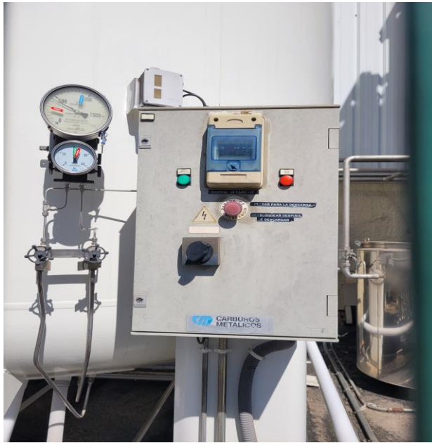
Figura 30. Medidor y ajuste de presión inicial de CO 2
