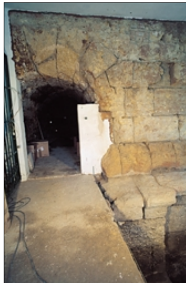
Lienzo y podio correspondientes a la fachada occidental de la puerta romana
