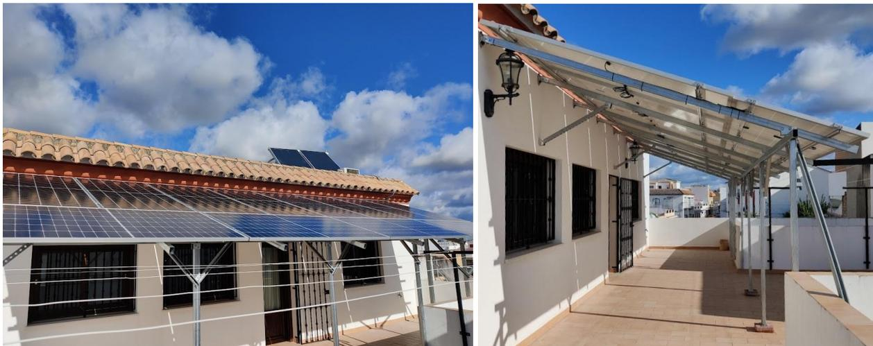
*Figura 3.1 Instalación fotovoltaica propia*
