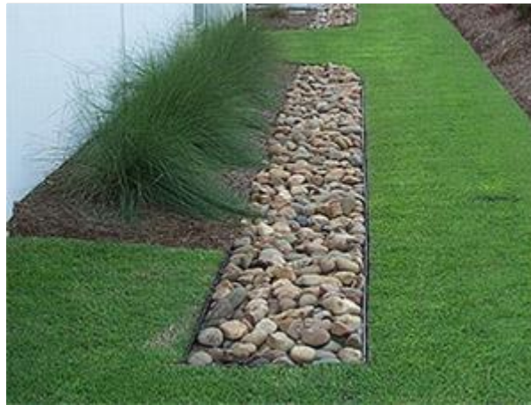
Figura 27: Trinchera de infiltración adoptada en el jardín
