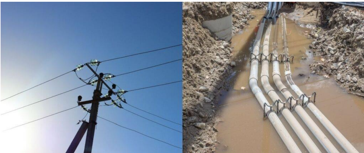
Figura 2-5. A la izquierda una línea aérea; a la derecha una línea subterránea.
