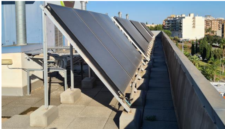
Ilustración 25. Baterías conexas en serie instalación Paterna (auditoría). Fuente: Propia
