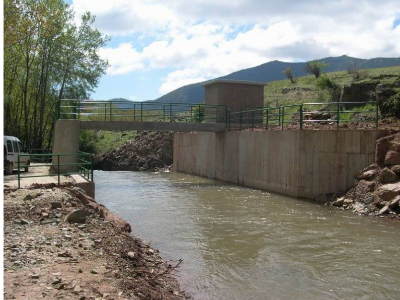
FIGURA 31. ESTACIÓN DE AFORO SOBRE EL RÍO EBRO.
