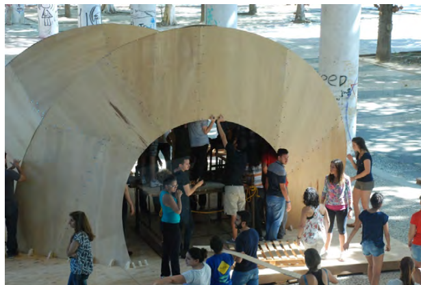
Fig. 7. Montaje del Pabellón a escala 1:1. FAU, Universidade Federal do Rio de Janeiro.
