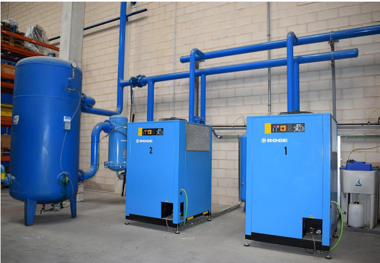
Figura 1.3: Detalle de instalación de aire comprimido con compresores y tanque [9]
