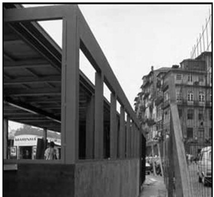
Café do Cais. Imagen mostrando las viguetas de cubierta
