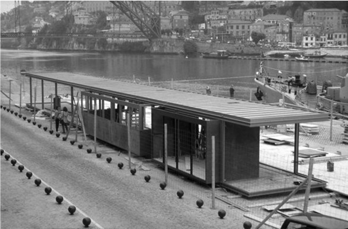
Café do Cais, en construcción. Vista superior, mostrando la estructura y la cubierta de zinc.
