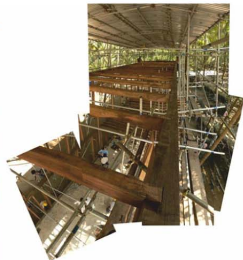
Casa Palmyra. Detalle del apoyo de las viguetas en las vigas
