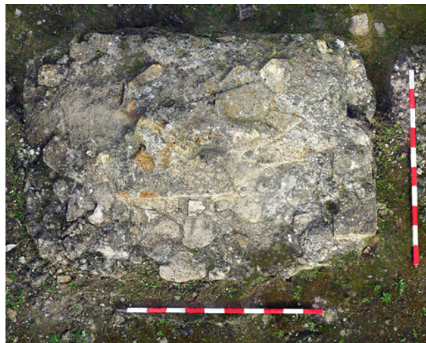
FIG. 9 Cimiento del basamento para escultura de la exedra semicircular noreste. Foto A. López Núñez y (autor).
