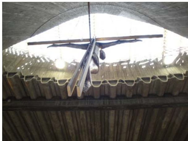
Figura 5. Lucernario y vigas hueso.
