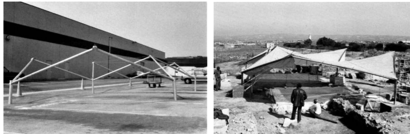
Imagen 13: La estructura de la cubierta «Hexashelter». El montaje de prueba (izquierda) y la construcción de la cubierta en Noviembre de 1989 (derecha) (Agnew y Coffman 1991).
