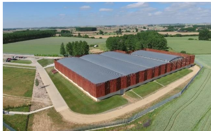
Imagen 14: Cubierta de tipo cerrada en el yacimiento de Villa Romana La Olmeda, Pedrosa de la Vega ( https://www.palenciaturismo.es/visitar/lugares-interes/villa-romana-olmeda Fecha de acceso: 23.11.2023)
