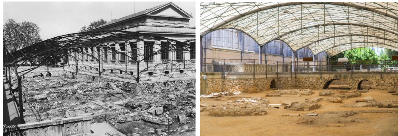
Imagen 20: Bóvedas vaídas de Emilio Pérez Piñero, 1972. Proceso de cubrición de la necrópolis Paleocristiana de Tarragona (Pérez Almagro 2013)
