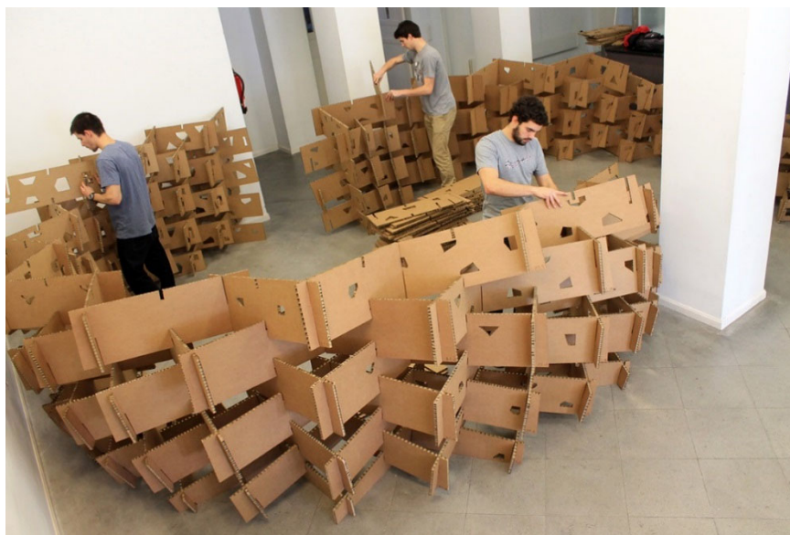
FIGURA 3. Pabellón de cartón en base a diseño paramétrico desarrollado por estudiantes de País Vasco.
