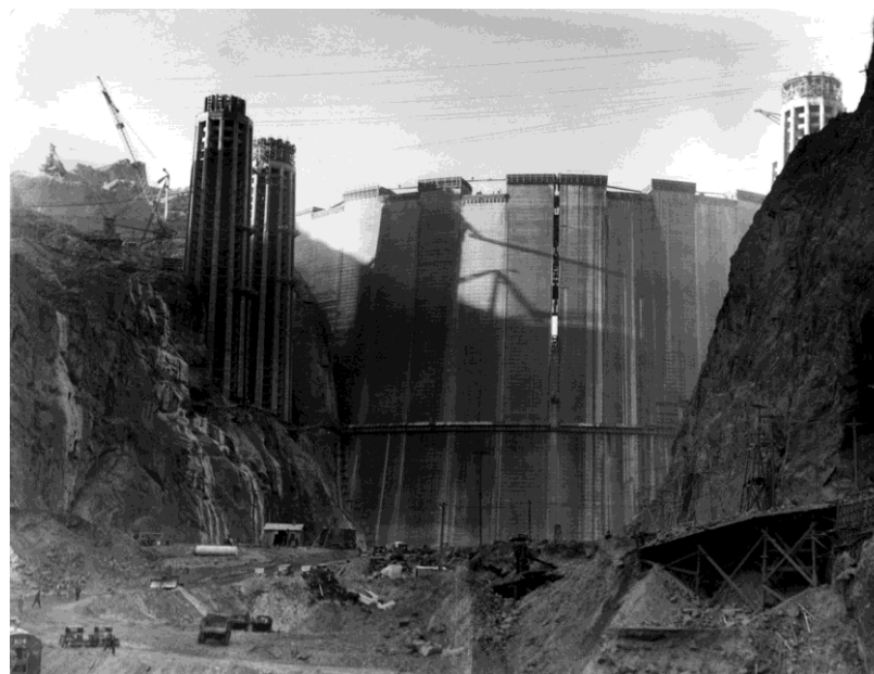
Figura 17. Construcción Presa Hoover (1933-1935)
