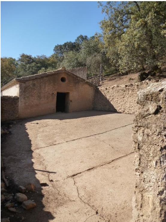
**Figura 21:** Zahúrda (criadera) con la entrada del tamaño de los cerdos, una ventana de ventilación y el corral frente a la entrada. El muro del corral tiene aproximadamente 1,50m de altura. El cemento en el corral es reciente. Fuente: elaboración propia, Finca de Riscos Altos, Cazalla de la Sierra, 18 de abril de 2023.
