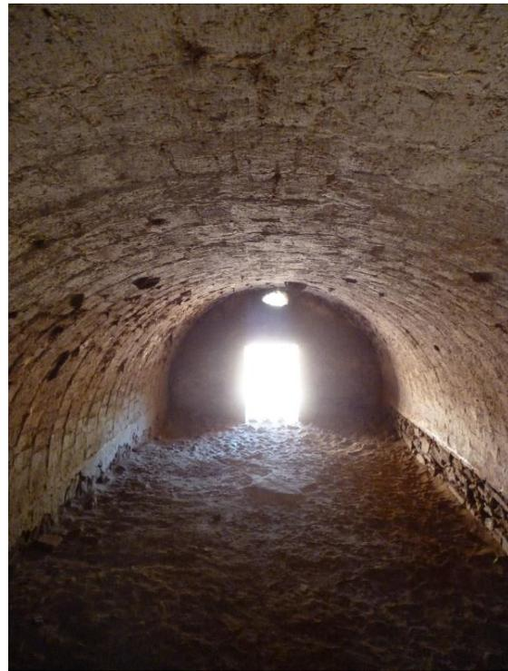
**Figura 23:** Interior de la zahúrda que se ve en figura 18, con bóveda de cañón y polvo en el suelo. Fuente: elaboración propia, Finca de Riscos Altos, Cazalla de la Sierra, 18 de abril de 2023.
