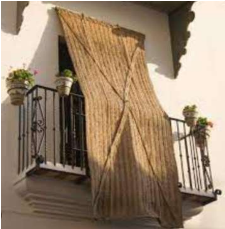
Figura 59. Persiana de esparto tradicional de Bujalance. Fuente: elaboración propia. Fotografía realizada a una vivienda de Bujalance
