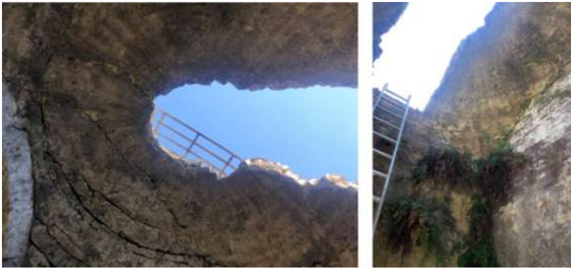
Figura 65. Estado previo del Aljibe del Castillo-Alcazaba. Fuente: Elaboración propia
