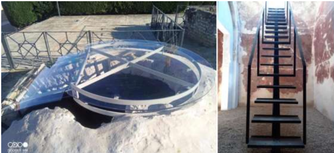
Figura 68. Fotografías del estado modificado del Aljibe del Castillo-Alcazaba. Fuente: Elaboración propia
