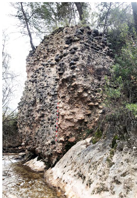
Fig. 16. Vista del estribo izquierdo de la presa, aguas abajo. Todavía se aprecian los restos del revestimiento de cal original, así como los mechinales para el alojamiento de las medias agujas de tñal. Fuente: autor.
