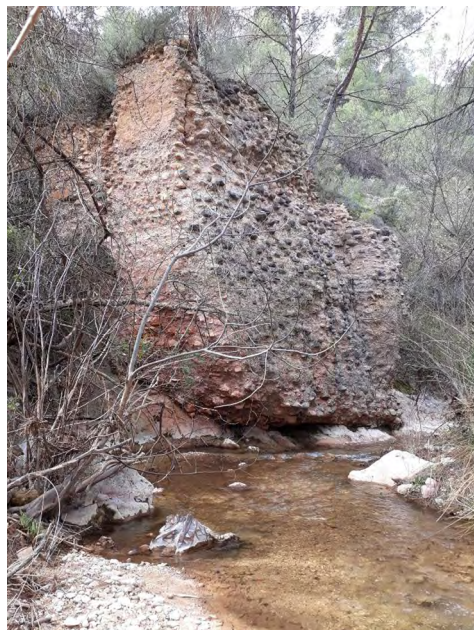
Fig. 1. Imponentes restos del estribo izquierdo de la presa al comienzo de la garganta o desfiladero del ciervo sobre el cauce del río Trujala en el municipio de Segura de la Sierra (Jaén). Fuente: autor.
