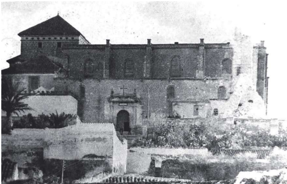
Fig. 18. Colegiata de Osuna. Derrumbe de 1918.
