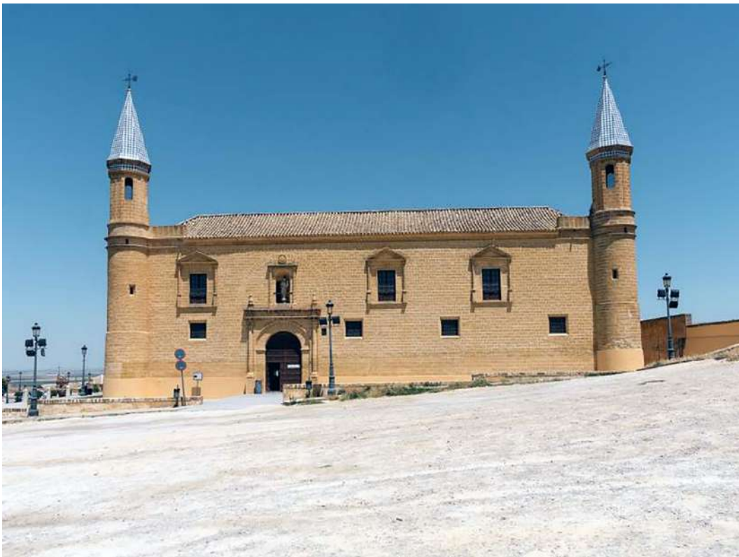
Fig. 11. Antigua Universidad de Osuna. Vista de la fachada este del edificio.
