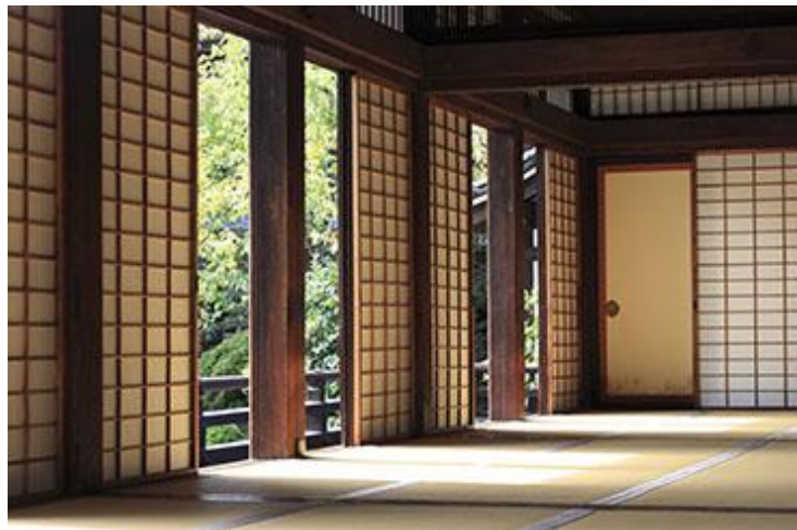
Figura 9: Los shojis plegados dejan pasar la luz al interior. Acceso en: https://www.ishikawa-tatamiten.com/slidingdoor
