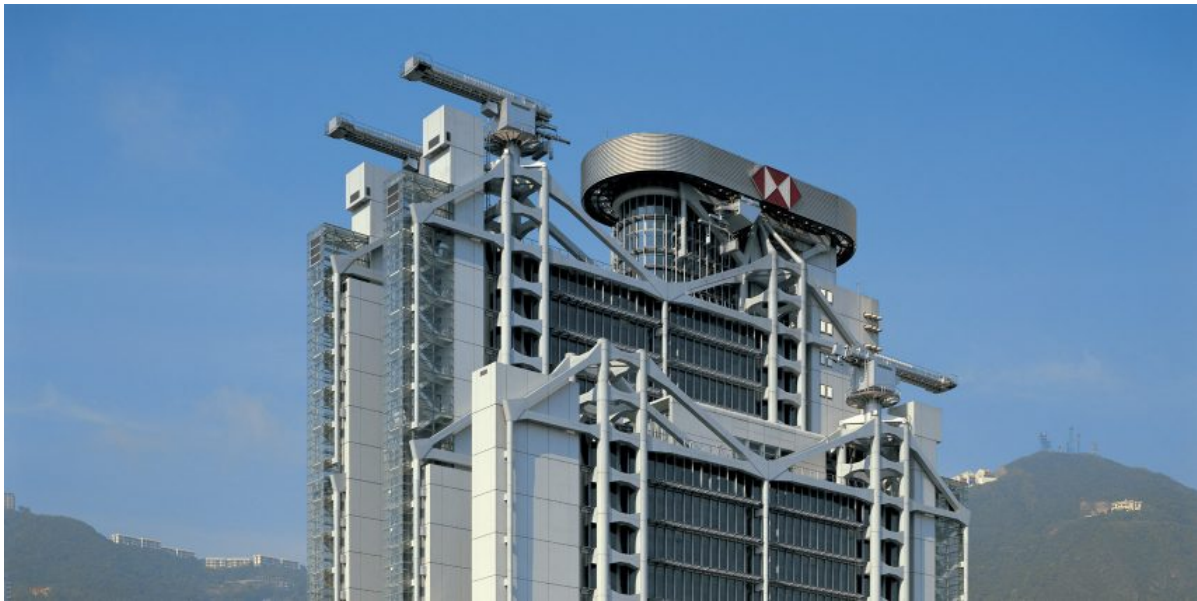
Figura 30: Las estructuras similares a cañones en lo alto del edificio HSBC.
