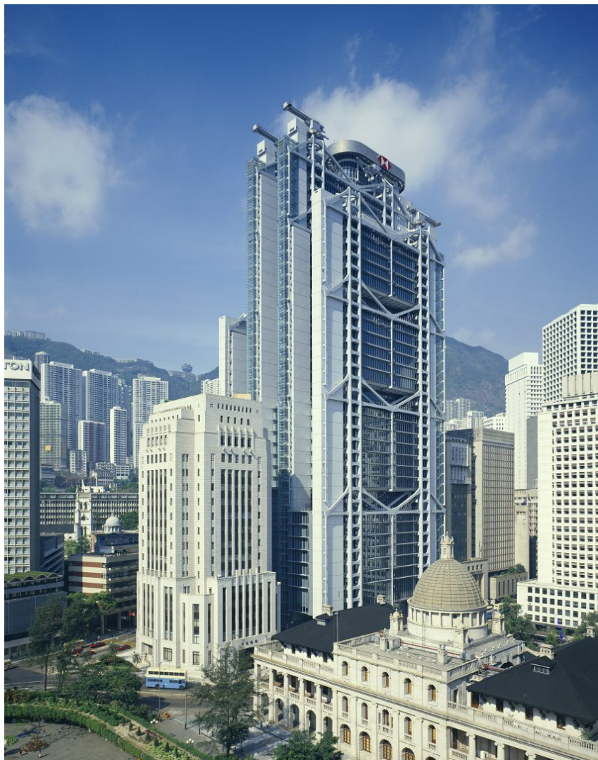
Figura 28: Edificio del banco HSBC en Hong Kong.
