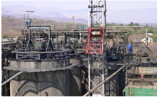
Figura 8. Planta industrial de pre-tratamiento biológico en Fairview, Sudáfrica. Fuente: Kaksonen, Mudunuru, et al. (2014).
