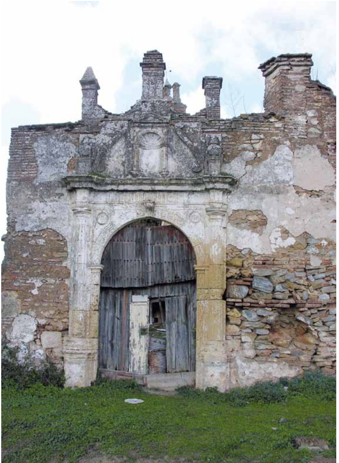
27.- Ermita de la Yedra. Portada de piedra de estilo renacentista, sobre los muros de mampostería y ladrillo anteriores. Memoria (inédito), 2006, II, fig. 40.
