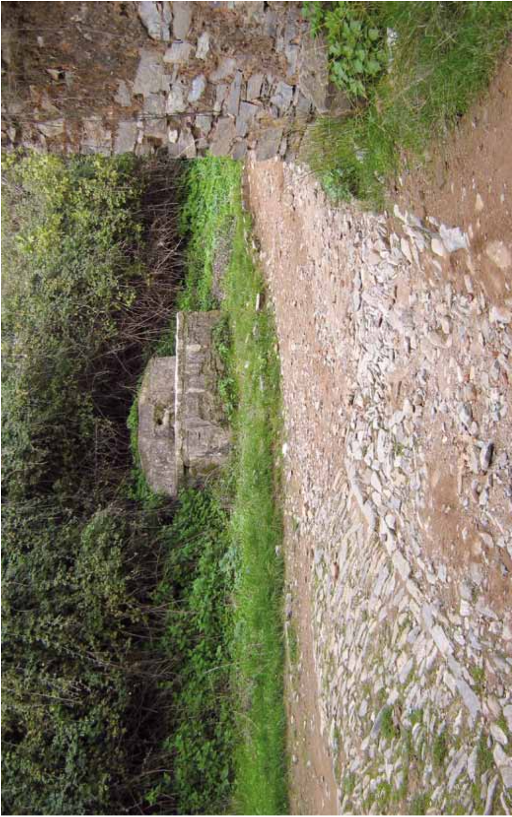
20.- Fuente del Chorrillo. La acequia corre a espaldas de la fuente, oculta por la vegetación. Puede apreciarse el excelente trabajo del empedrado original del camino, que todavía conserva parcialmente el encintado; y la esquina de uno de los tradicionales muros de mampostería que delimitan las parcelas. M.T. Henares. 2009.
