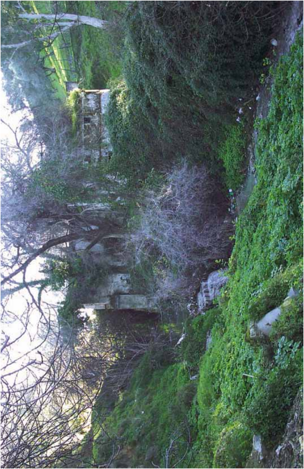
21.- Molino hidráulico sobre el "Río Allende" (el Arroyo de la Villa, aguas abajo de la población). El arroyo corre de izquierda a derecha de la imagen. Al pie del molino se aprecia la represa de mampostería sobre la que salta el agua. M.T. Henares. 2009.
