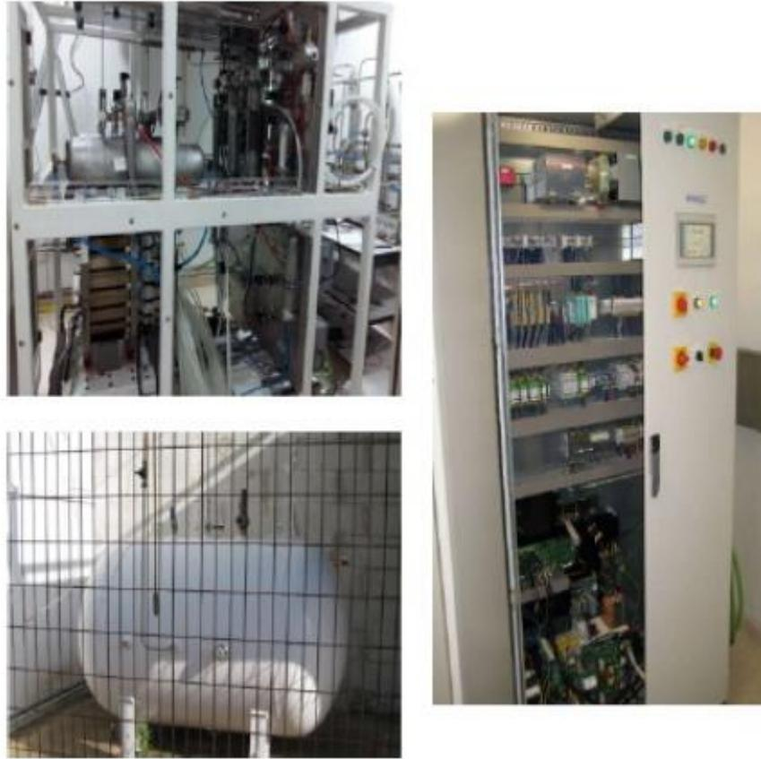
*Figura 4.6: Electrolizador y depósito de hidrógeno. Fuente: [30]*
