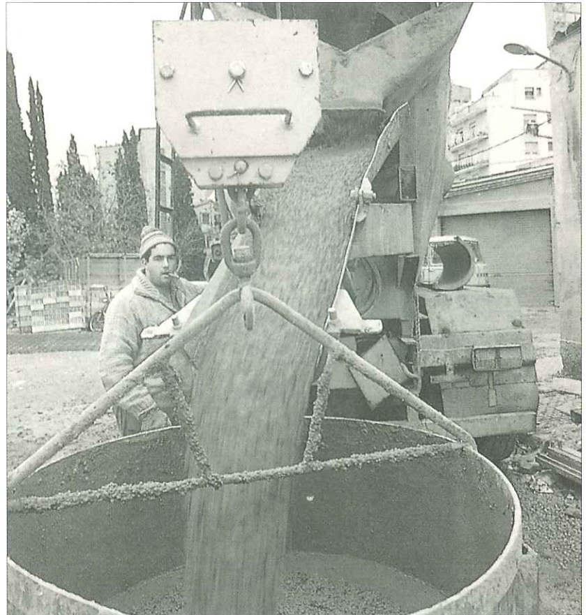
Suministro de hormigón preparado
