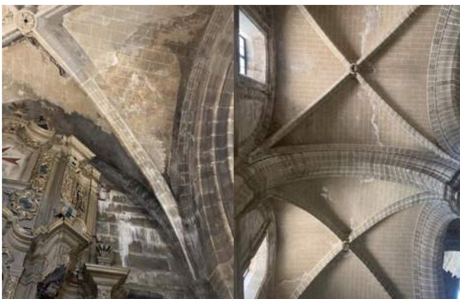
Ilustración 15: Manchas de humedad y eflorescencias salinas en las cubiertas. Problema generalizado en las techumbres del templo. [Imágenes tomadas por Pablo Tejero Cárdenas, 2023]
