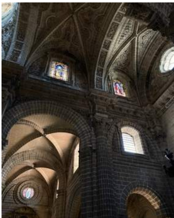
Ilustración 18: Sistema de iluminación natural. Puede observarse la altura a la que se encuentran los vanos, lo que hace que la luz solar no incida de forma directa en la gran mayoría de los bienes. [Imagen tomada por Pablo Tejero Cárdenas, 2023]
