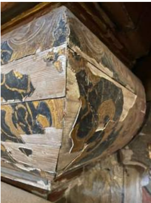
Ilustración 24: Separación de piezas de soporte, levantamientos en el estrato polícromo y lagunas de policromía. [Imagen tomada por Pablo Tejero Cárdenas, 2023]
